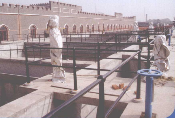
36 万吨示范工程滤池
