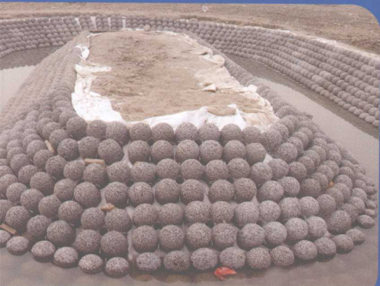
生态混凝土球块的铺设
