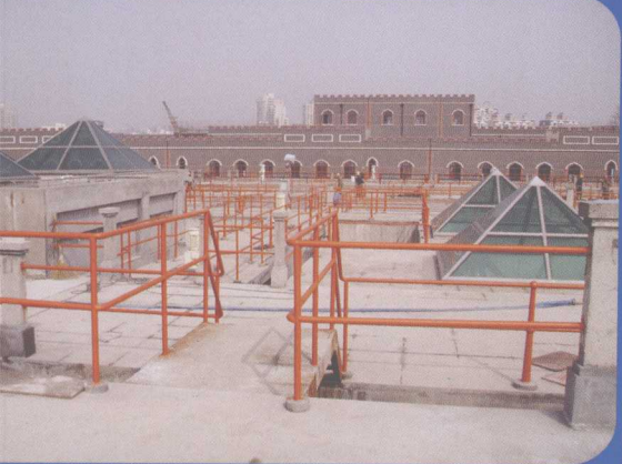
36 万吨示范工程高效澄清池
