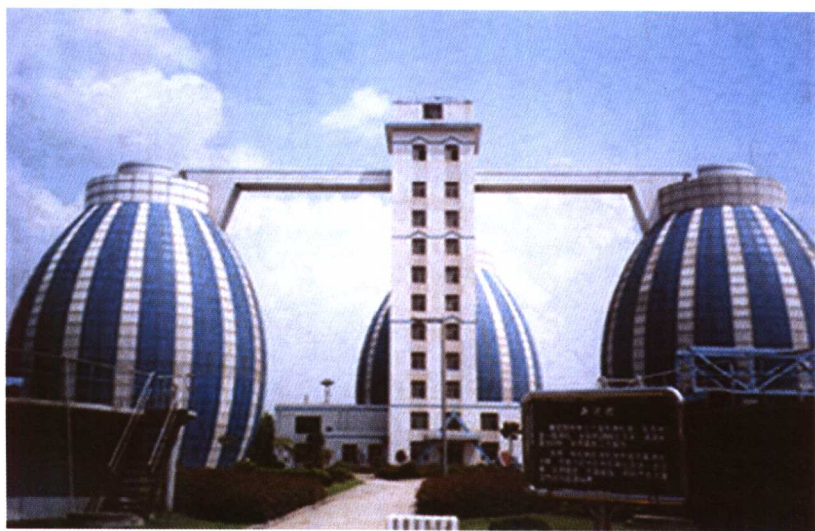
杭州污水处理厂蛋型消化器
