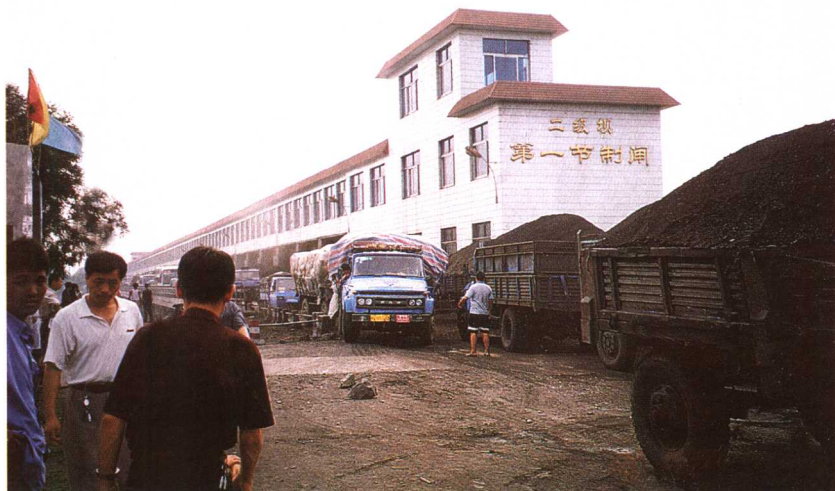
济宁运河节制闸
