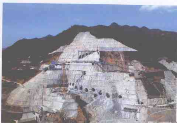
▲ 2004年4月大坝工程施工全貌
