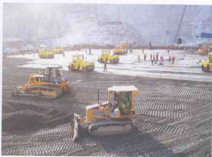
▲ 大坝碾压混凝土施工
