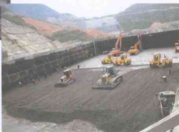
▲ 碾压混凝土平仓
