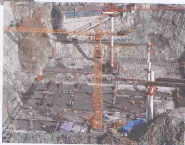
▲ 2004年12月大坝工程施工全貌
