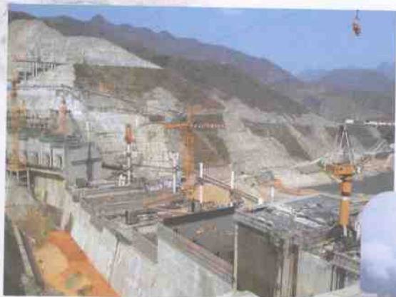
▲ 2006年4月大坝工程施工全貌
