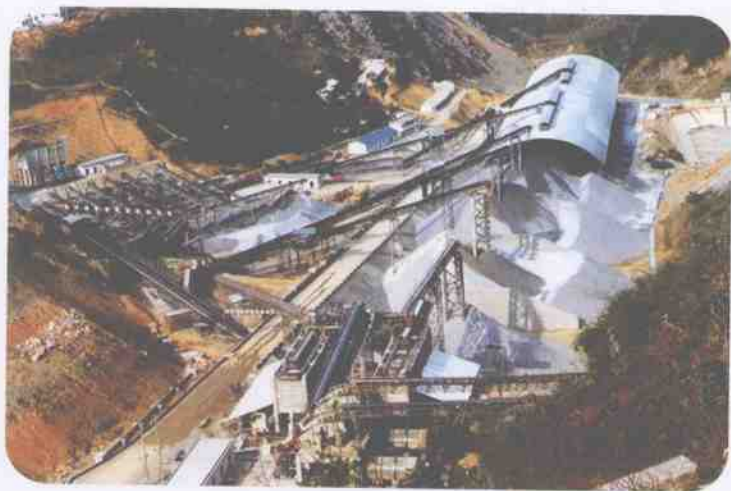
▲ 大法坪人工砂石料加工系统
