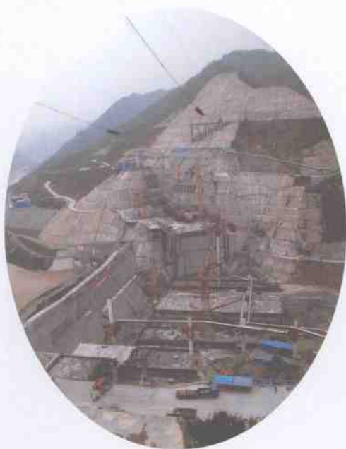
▲ 2005年3月大坝工程施工全貌
