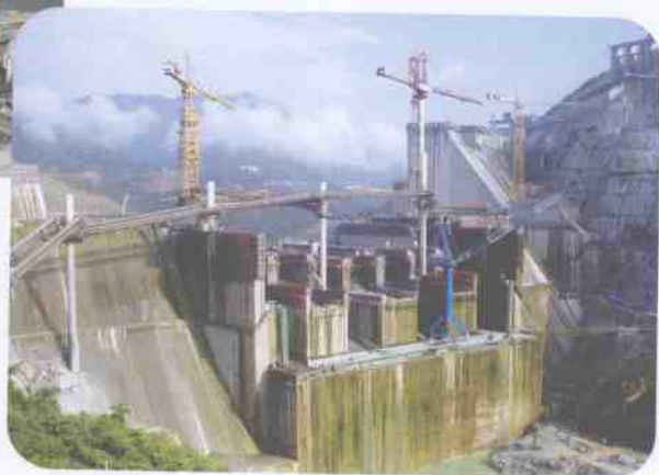
▲ 2006年6月大坝工程施工全貌
