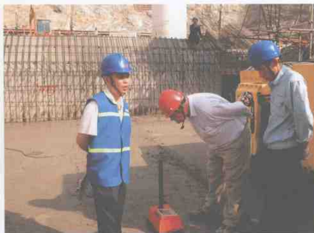
▲ 碾压混凝土压实度检测
