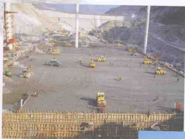
▲ 大仓面碾压混凝土施工
