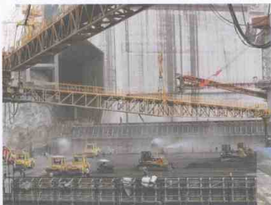
▲ 碾压混凝土仓面施工
