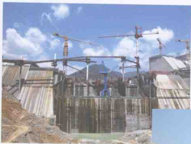
▲ 2006年8月大坝工程施工全貌
