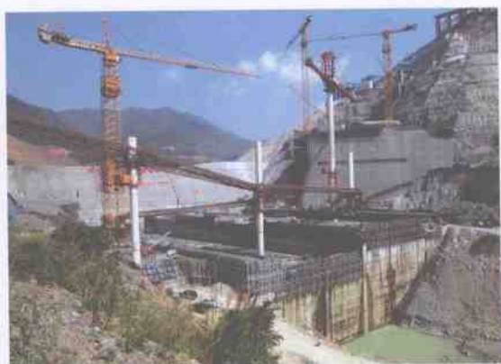
▲ 2005年5月大坝工程施工全貌
