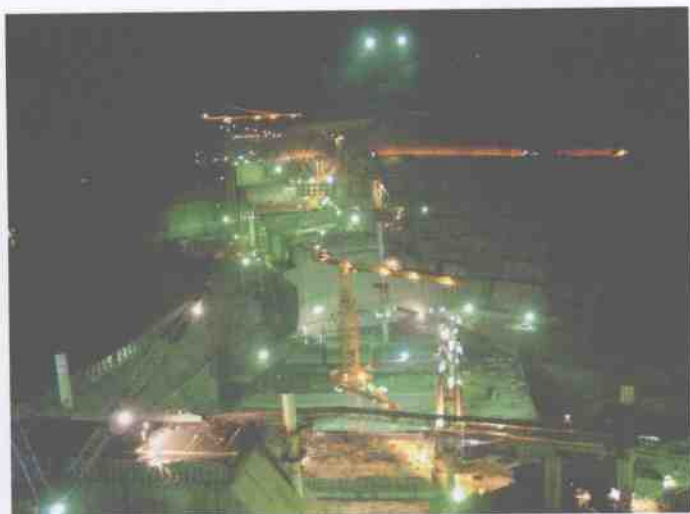
▲ 大坝工程施工夜景
