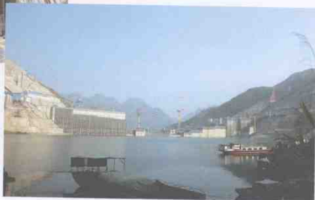
▲ 2007年3月大坝工程施工全貌
