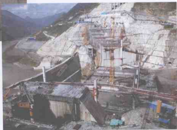
▲ 2005年11月大坝工程施工全貌
