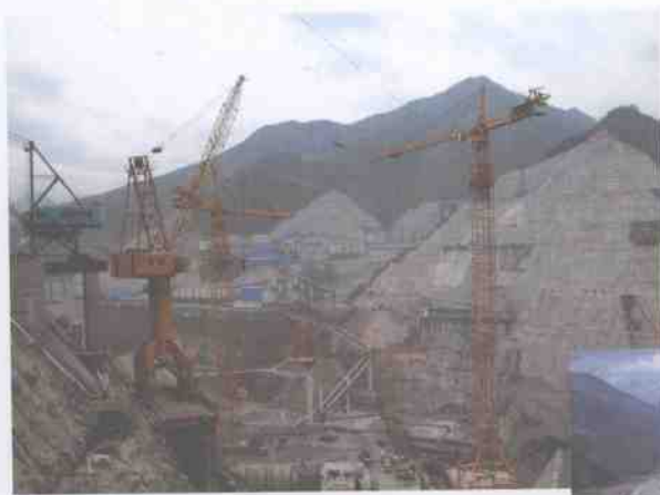
▲ 2005年8月大坝工程施工全貌
