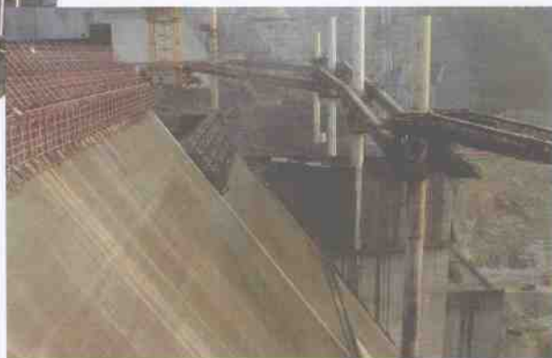
▲ 碾压混凝土坝外观
