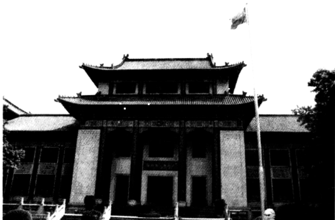
广州市人民政府大楼
