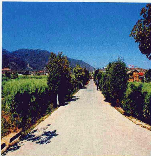
新农村水泥硬板路
