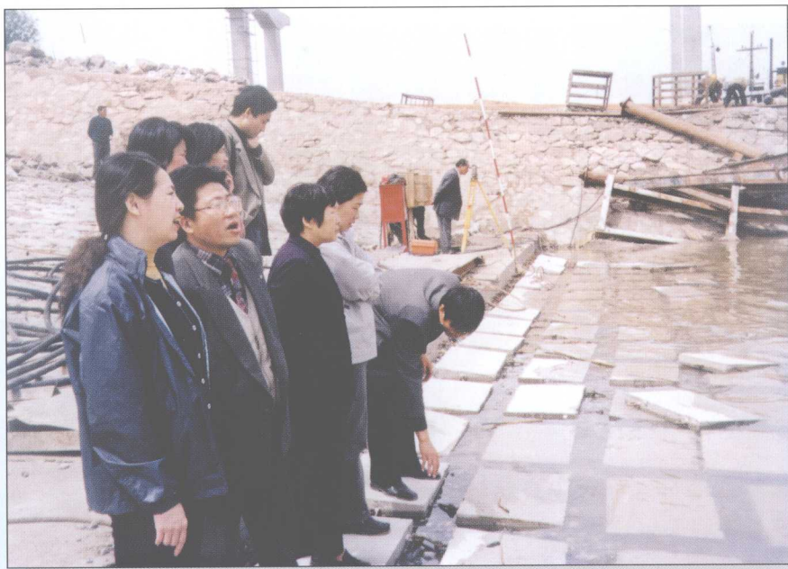
为提高教学质量，使理论与实际相结合，长江水利委员会教育中心经常选派教师到水利工地实践和考察。图为教师们正在湖北省鄂州耙铺大堤考察
