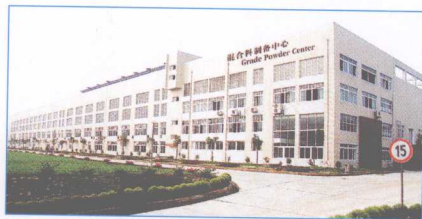
混合料制备中心
