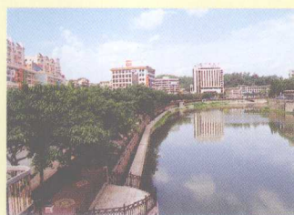
建成后的截污管道
