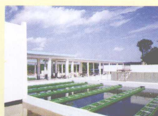
第一水厂沉淀池
