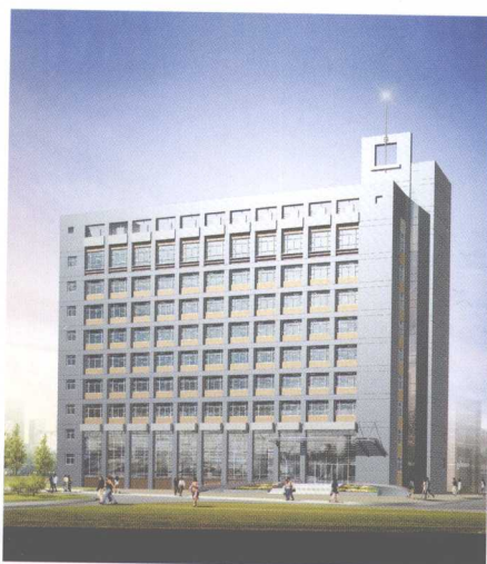
陕西省石头河综合办公楼
