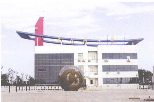
辽宁大伙房水库调度中心
