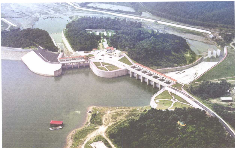
辽宁大伙房水库 非常溢洪道
