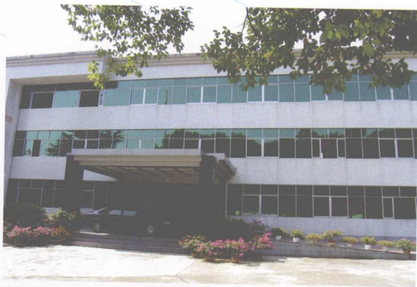
湖南芷江春阳滩水电 有限公司办公大楼
