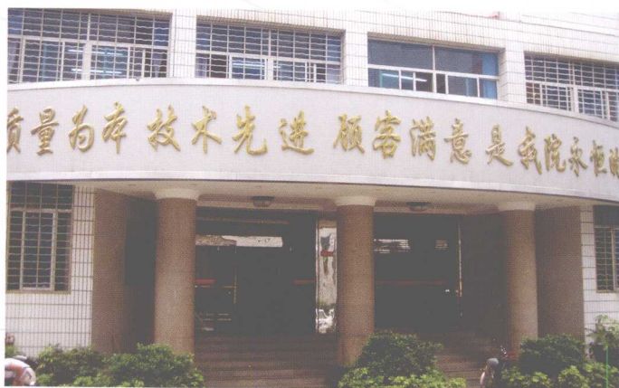
云南省水利水电勘测设计研究院办公大楼
