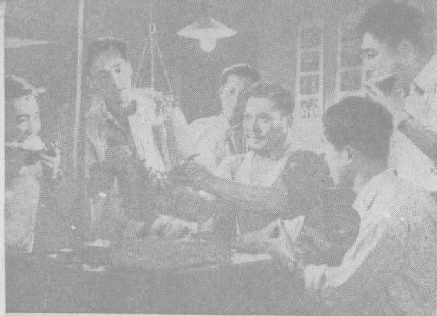
老師傅和技術人員 正在試驗鋼模鋼錠雙吊 法。
