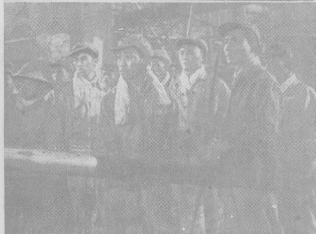
第一號化鐵爐漏底 了，余志剛奮勇搶救。
