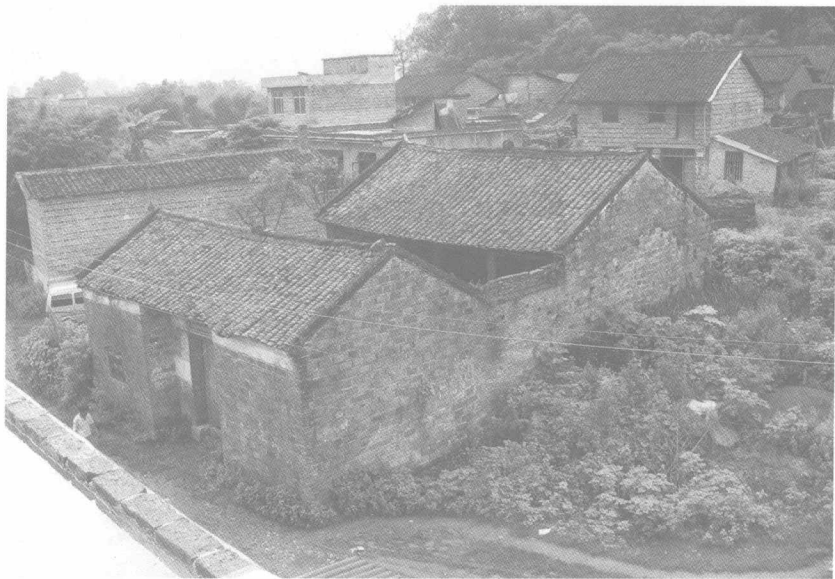
单檐硬山顶、青砖木瓦结构、两进一井三开间布局的周氏宗祠（融水苗族自治县融水镇东良村）
