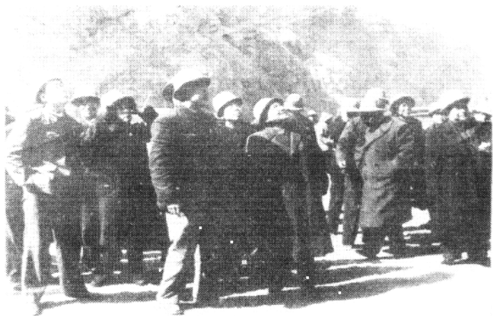
1966年3月19日，邓小平同志视察刘家峡建设工地。
