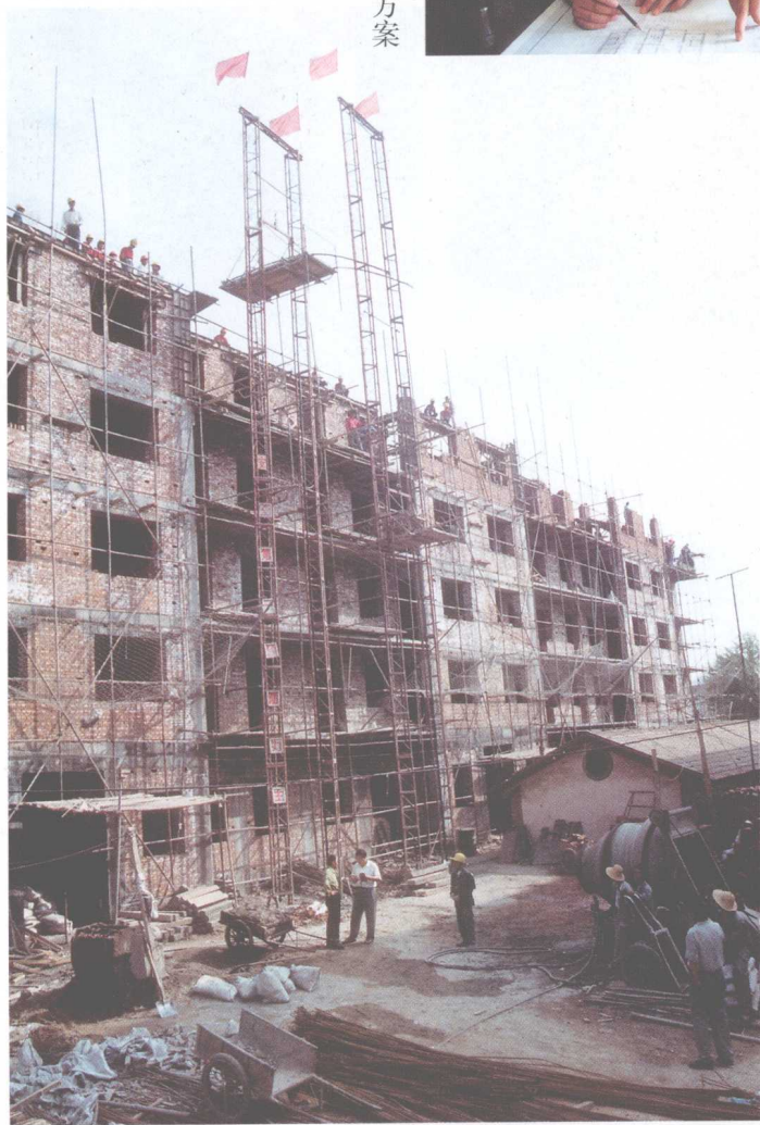
在建中的大楼
