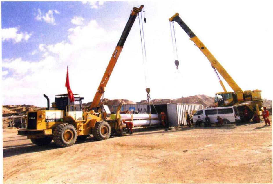
图7 2205 双相不锈钢管线现场施工
