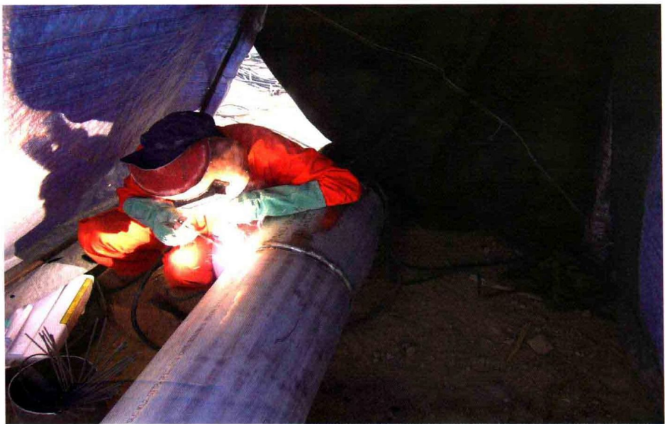
图8 2205 双相不锈钢管线现场焊接
