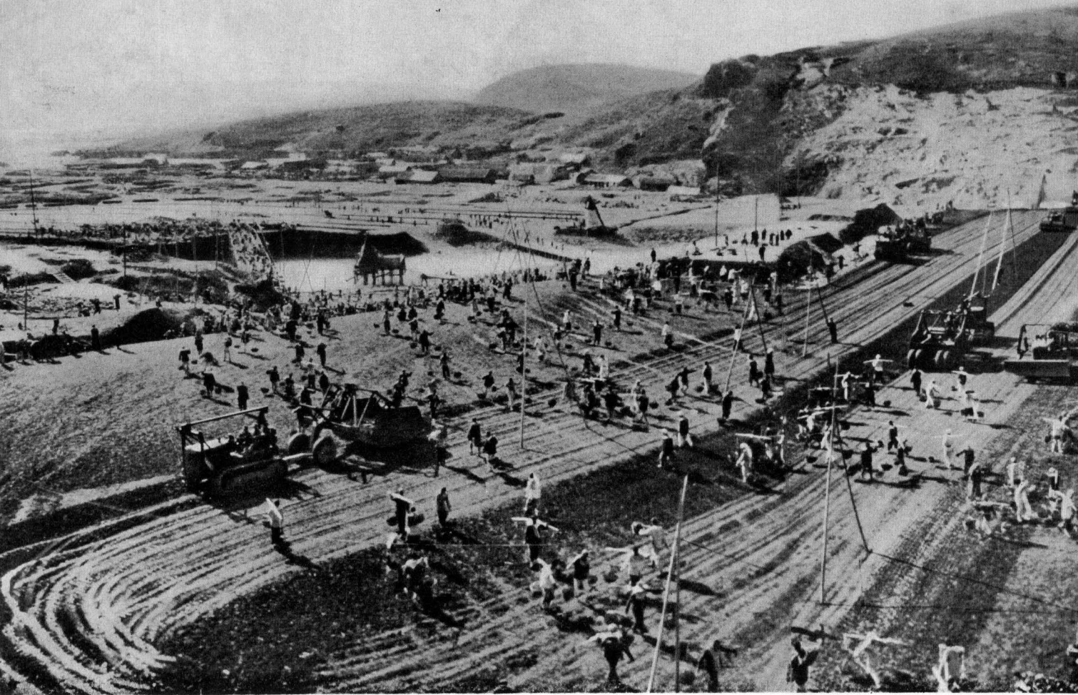
在統一的計劃下，千里淮河各個大小工程相繼施工。 這是淮河上游薄山水庫建築攔河大壩的工地。
