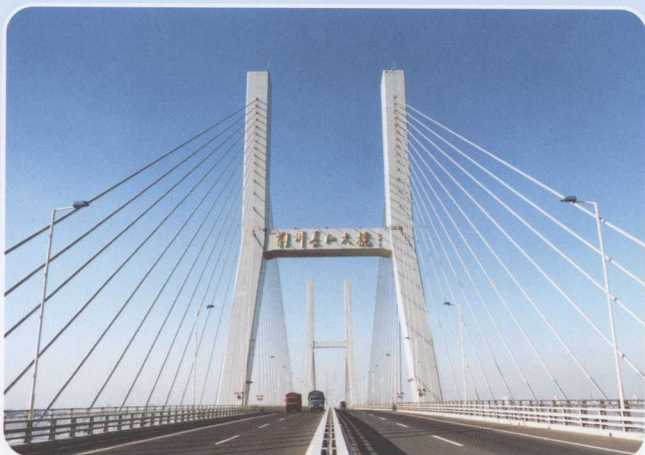
荆州长江大桥
