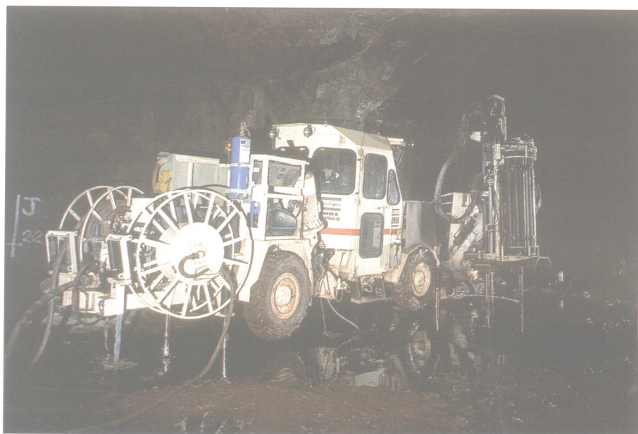
图 1. 阿特拉斯－科普柯公司 Simba H4356S 钻机，奥林匹克坝 (Olympic Dam)，澳大利亚南部
