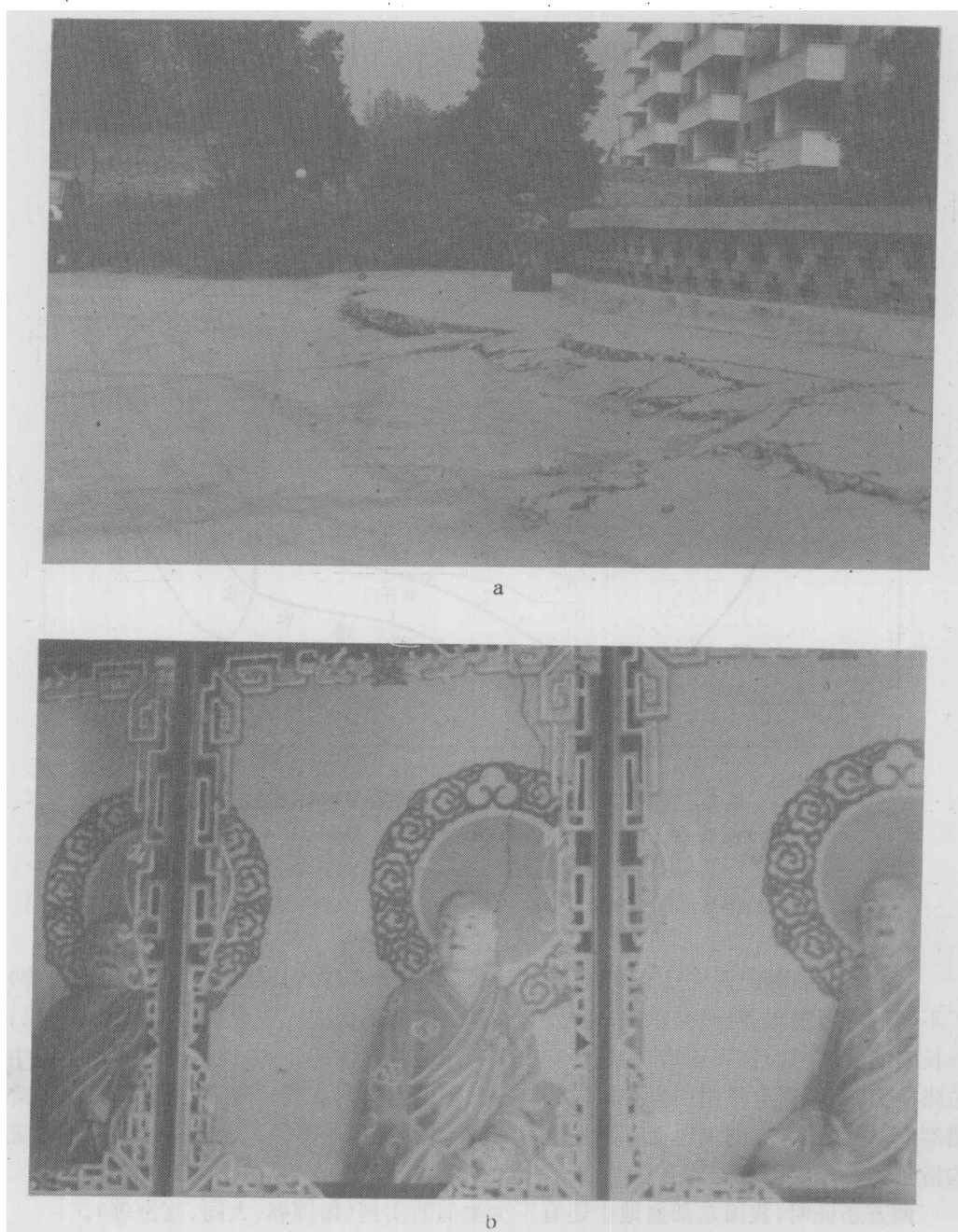
图4 西安地裂缝造成的破坏景观
