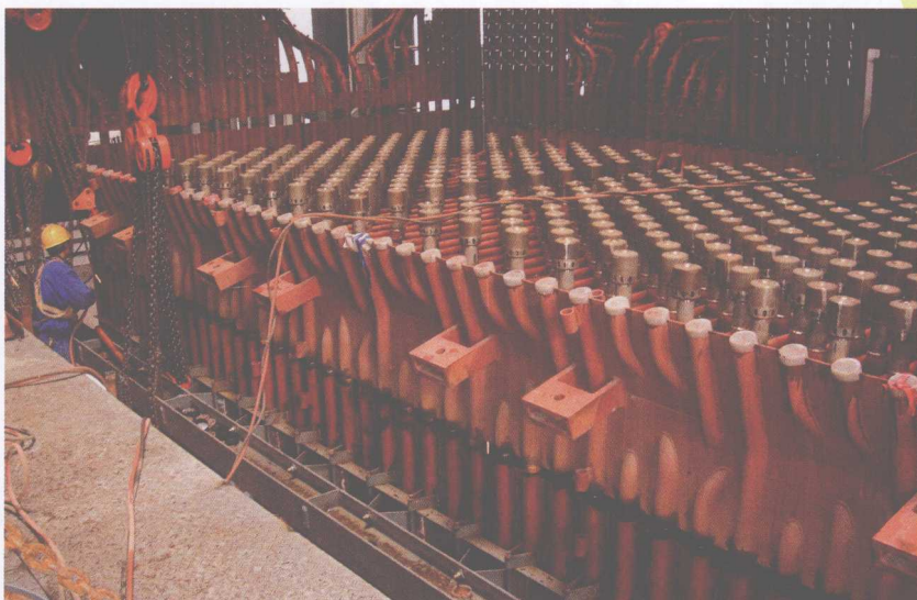
锅炉布风板安装
