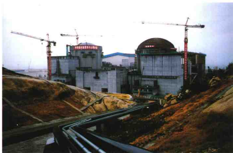
山东核电建设集团公司中标兴建的广州岭澳核电站常规岛外景
