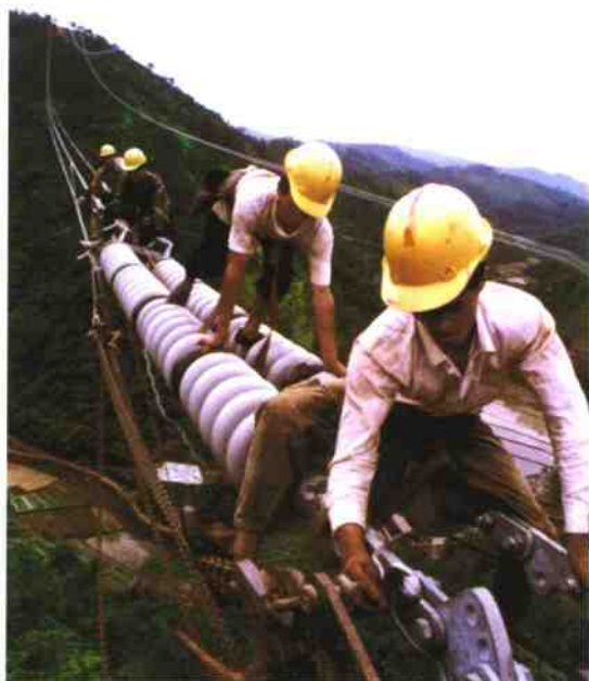
送变电职工正在野外紧张施工
