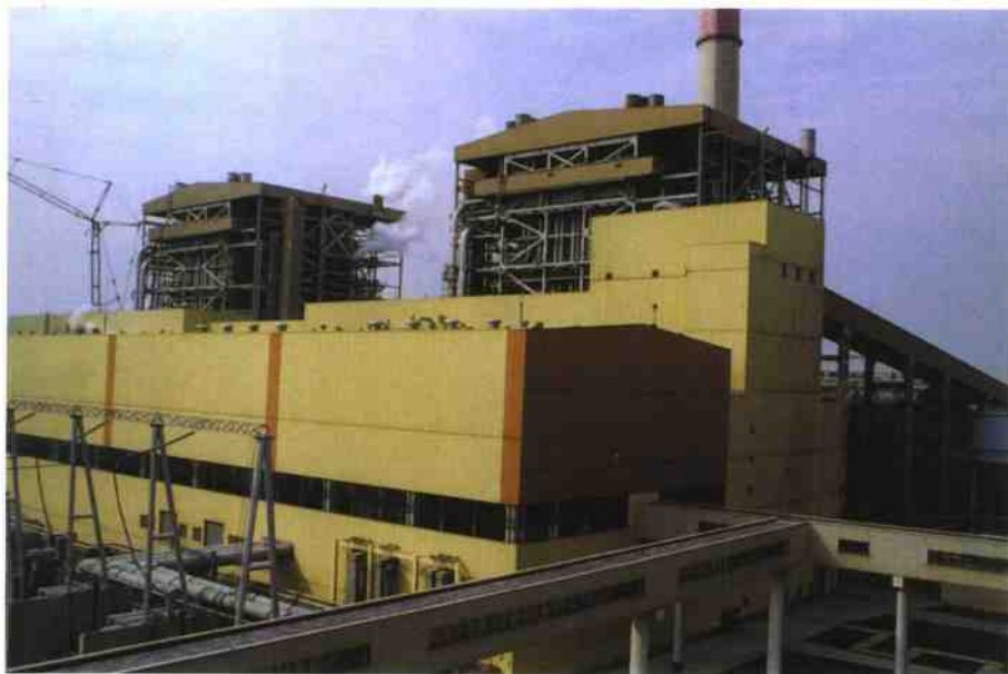
装机总容量120万千瓦的邹县电厂三期工程于1997年11月全部建成移交试生产。该工程1999年被评为中国建筑工程鲁班奖
