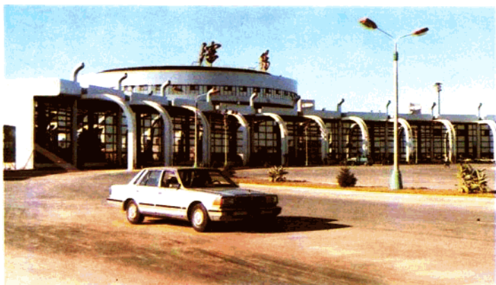
沈阳桃仙国际机场
