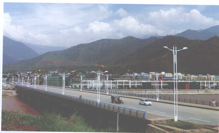
米易县安宁二桥建成通车
