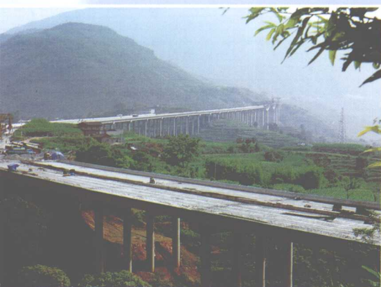
建设中的西攀高速公路
