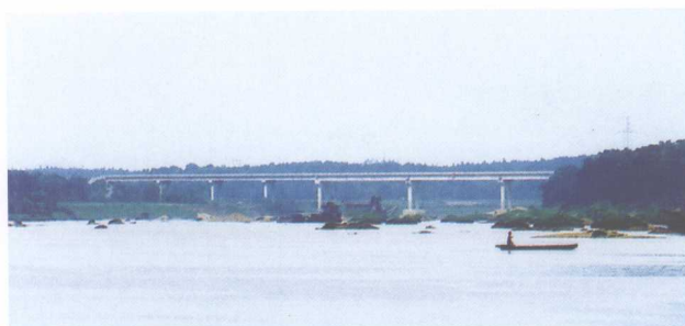
区境内 206 国道沙咀头大桥
