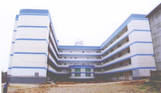
昌江一中科技大楼
