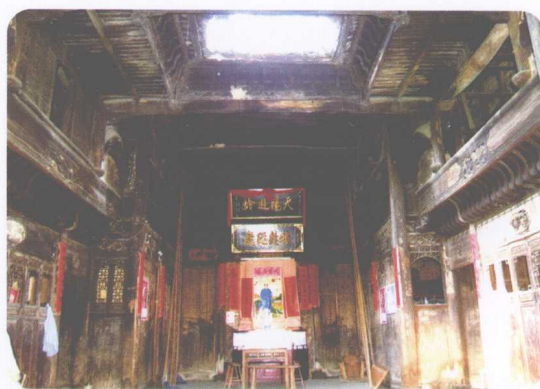
鲇鱼山镇坂上村古建民宅室内景
