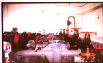
输油泵房安装
