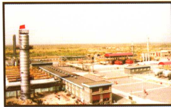
施工中的原油稳定工程
