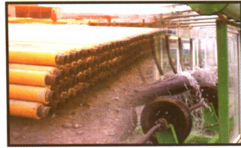
黄夹克防腐保温、三层PE防腐
