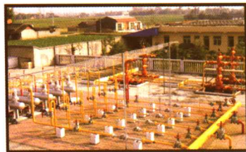
井口流程施工
