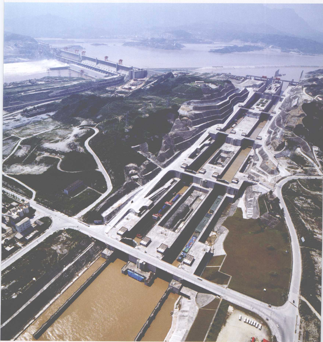
鸟瞰三峡工程双线五级船闸
