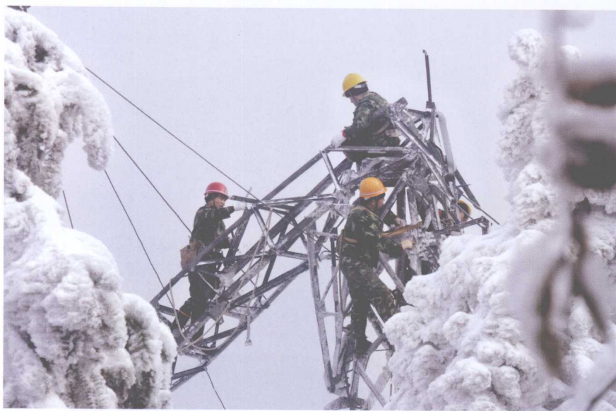
2008年1月29日，湖北电力的电工攀上结冰的铁塔抢修。
