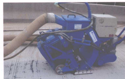
桥面喷砂凿毛
