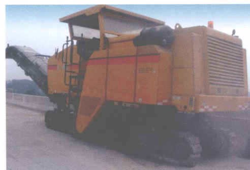
桥面浮浆铣刨
