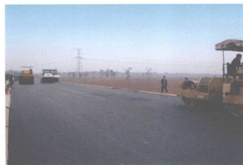
沥青面层施工
