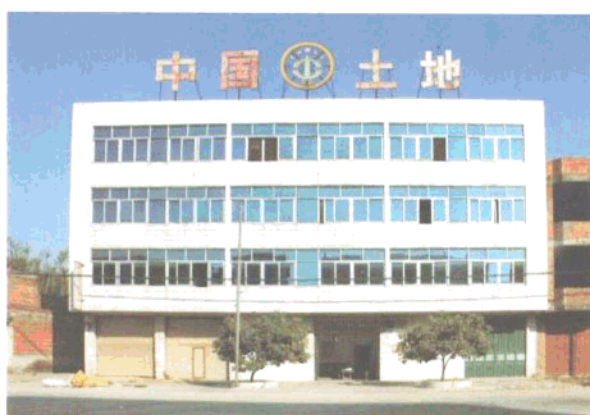
烟墩国土所办公住宅楼。
