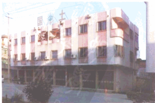
三海国土所办公住宅楼。
