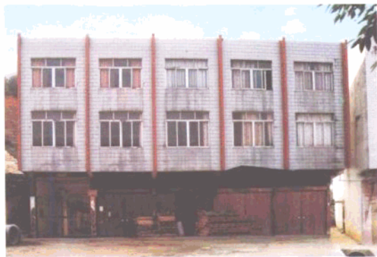
丰塘国土所办公住宅楼。
