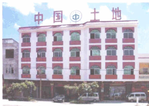
沙坪国土所办公住宅楼。
