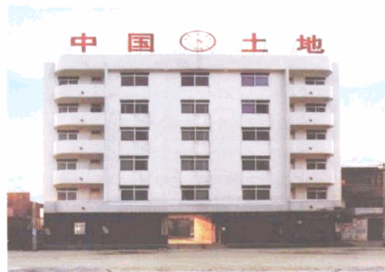
平山国土所办公住宅楼。
