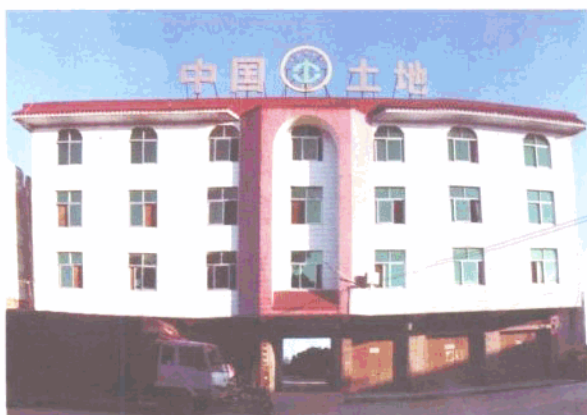
旧州国土所办公住宅楼。
