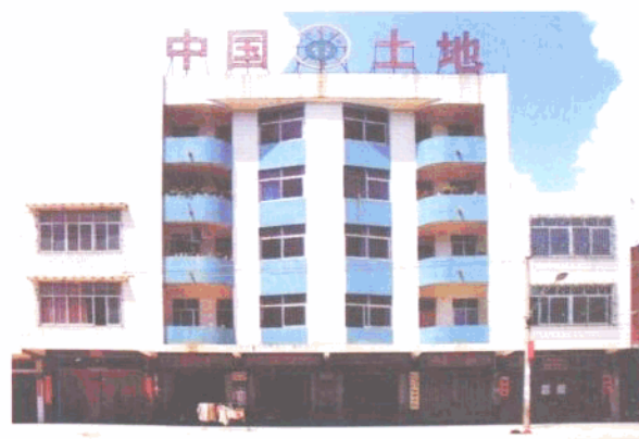
伯劳国土所办公住宅楼。
