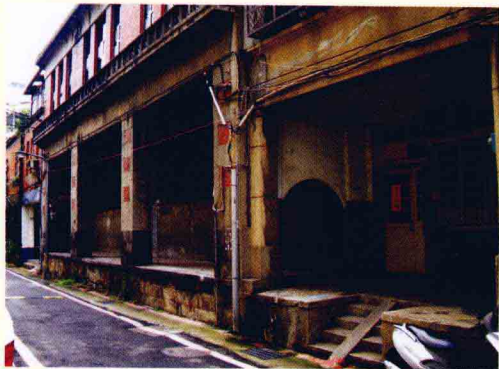
台北古茶街——贵德街的老建筑，为了防范台风季节的大水，骑楼的台基都高出地面尺余，是茶工聚集拣剔茶梗的地方
