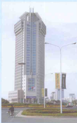
新世纪初建成的淮安电信大楼
