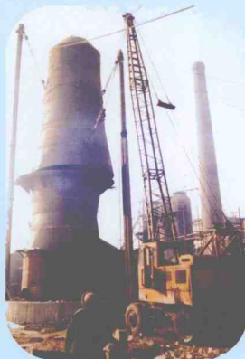
1986年11月27日淮钢建设成72立方米炼铁高炉，图为吊装时情形。
