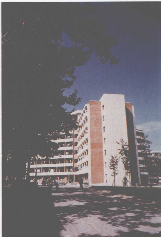
15 号楼研究生宿舍 (1986 年建成)
