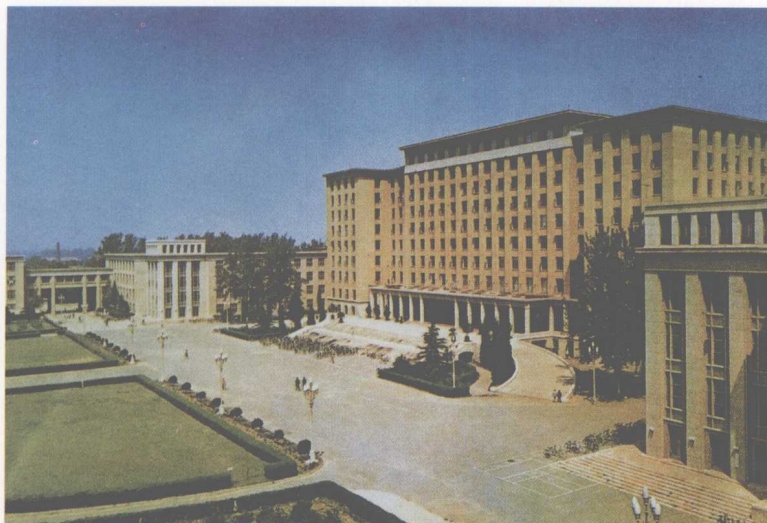
主楼(东西主楼始建于1956年,中央主楼建成于1966年)
