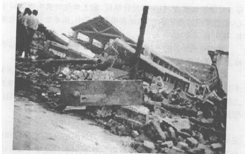
图 1.4(a) 1996 年 8 月重庆市上桥远益加油站因雷击发生爆炸燃烧使加油站房屋炸毁,死亡 4 人,直接损失 8.5 万元,间接损失 38 万元
