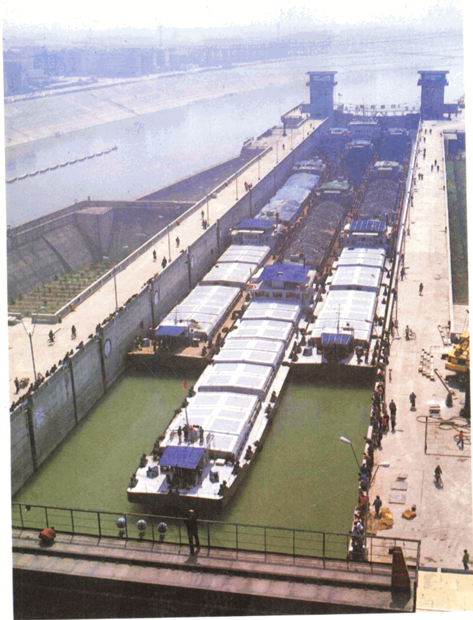
长江葛洲坝水利枢纽工程 2 号船闸
