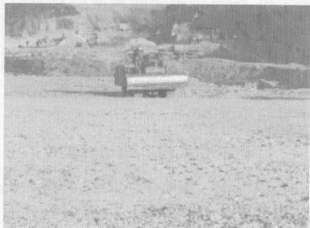
图 1-2 勉宁路施工现场
