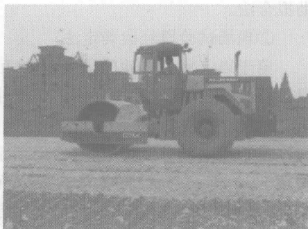
图 1-4 余杭段改建工程施工现场
