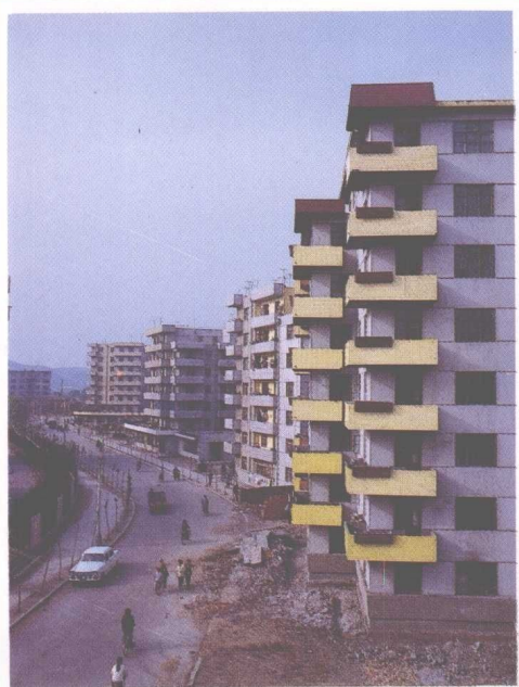
14. 千金路住宅小区
