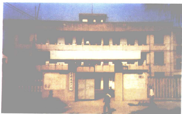
县水产局办公楼
