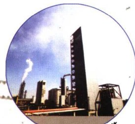
淮南化工总厂分馏塔
