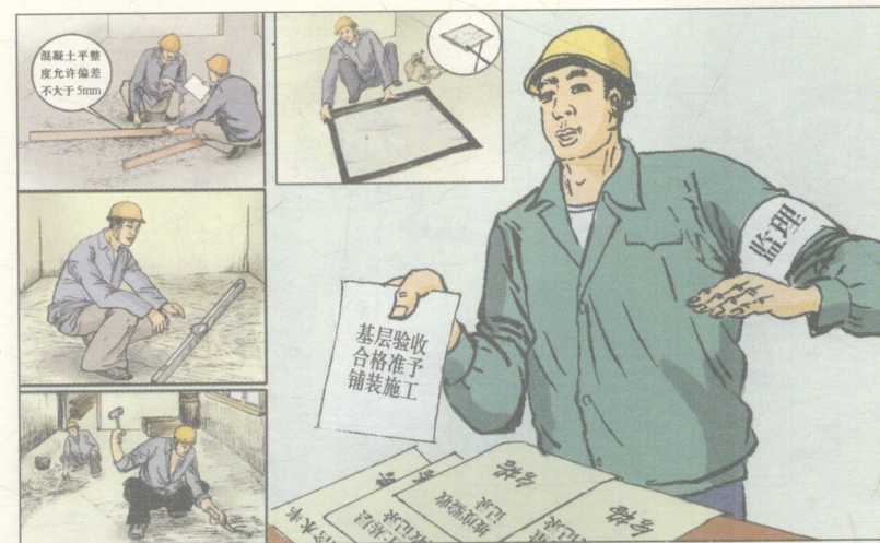
3.0.14 木质地板铺装工程应在基层质量验收合格并作检验记录后方可施工。对基层的缺陷应进行处理，并使之符合现行国家标准《建筑地面工程施工质量验收规范》GB 50209 的要求。
