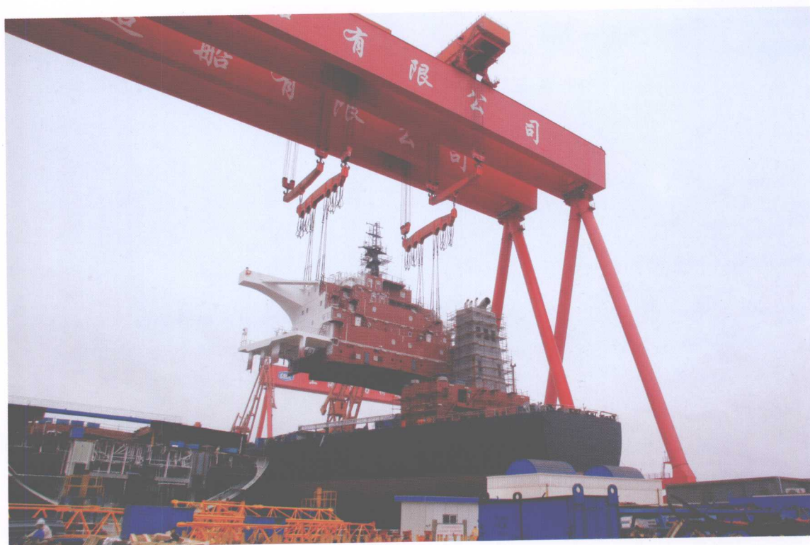
公司 1# 船坞两台 600 吨龙门吊成功联吊
