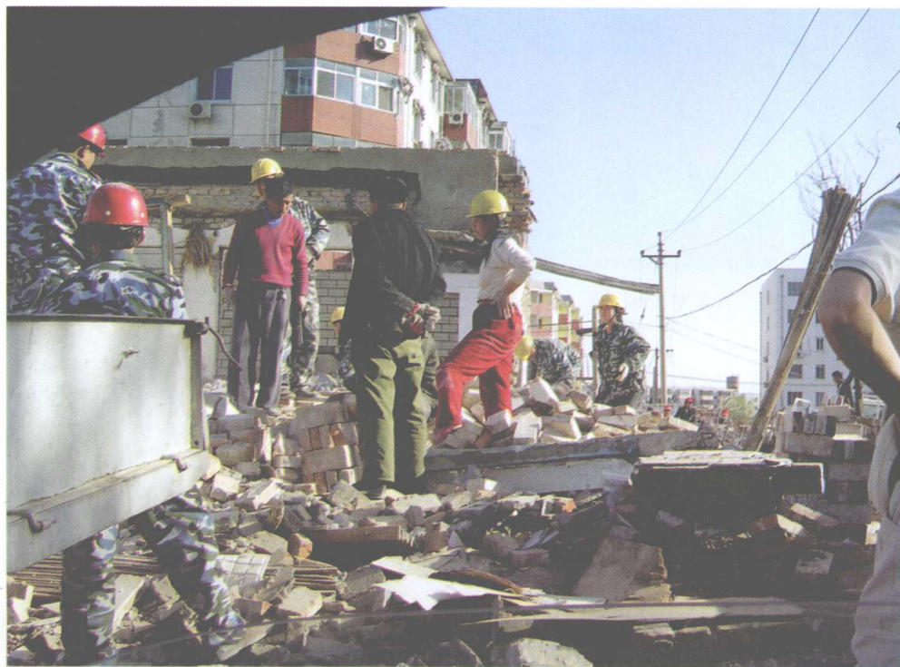
打工者拆迁旧房
