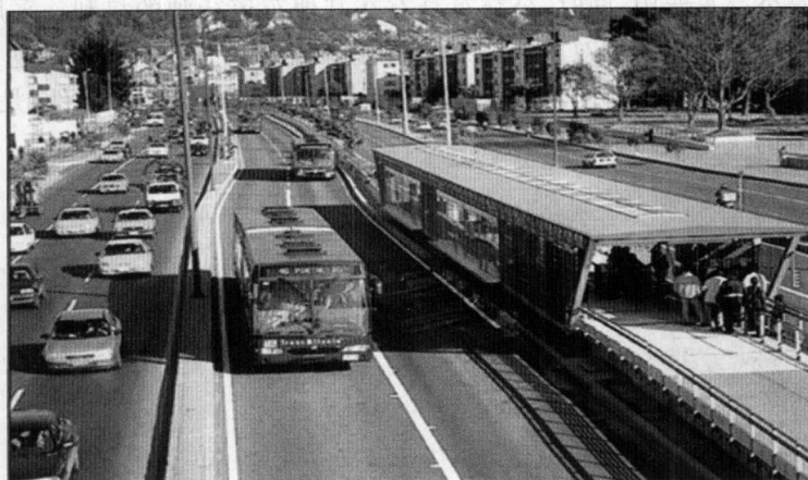
图 1-2 全封闭的公交专用路
