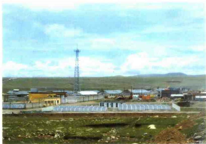
北京科诺伟业公司在西藏古路乡建设的 46kW 光伏电站
