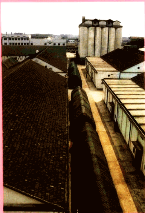
杭州市南星桥粮食仓库
