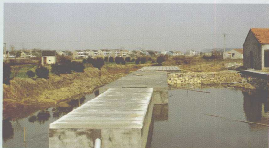
利用旧池塘 建造厌氧消化池
