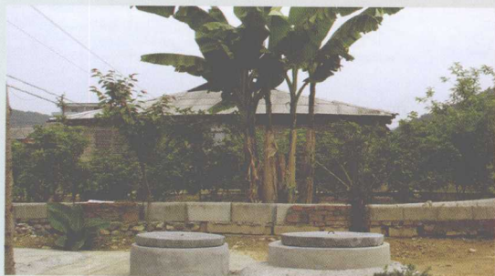
宁海潘银桑的沼气池
