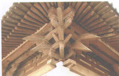
7-1 山西高平开化寺大殿角科斗拱（北宋熙宁六年，1073年，高平市陈堰镇舍利山）
