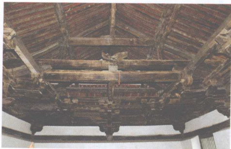
8-2 山西高平崇明寺殿内顶部露明梁架结构（北宋开宝四年，971年，高平市河西镇郭家庄村）
