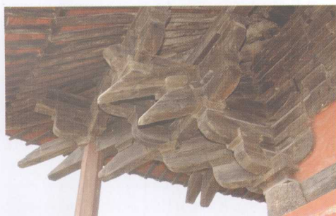
7-5 山西高平崇明寺转角斗拱（北宋开宝四年，971年，高平市河西镇郭家庄村）
