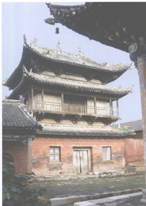
2-4 山西晋城崇安寺插花楼（始建于北宋，现存为明清建筑，晋城西北卧龙岗上）
