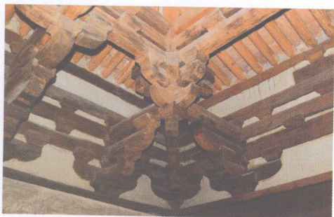
8-3 山西平顺大云院大佛殿内檐斗拱（五代，938年，平顺县实会乡实会村）
