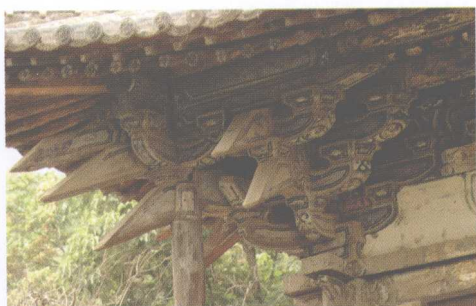
7-4 山西平顺龙门寺大雄宝殿角科斗拱（后唐同光三年925年）
