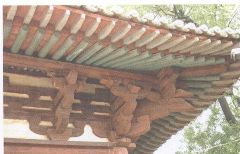
7-6 山西平顺大云院大佛殿角科斗拱（五代，938年，平顺县实会乡实会村）
