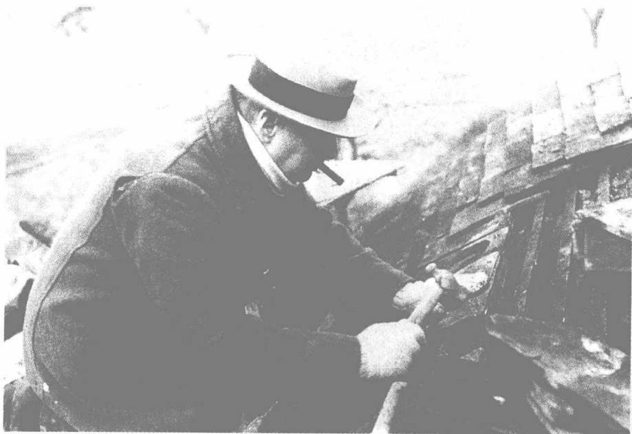
在野期间丘吉尔在铺瓦,大衣肩口开线了。
