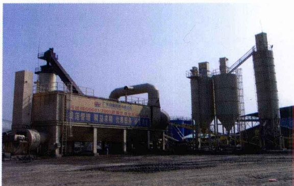
路面材料拌和场
