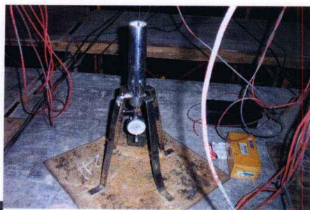
▲ 新旧桥纵缝连接试验段 挠度测点
