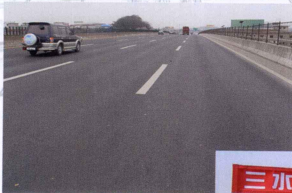
新旧桥纵缝连接后路况
