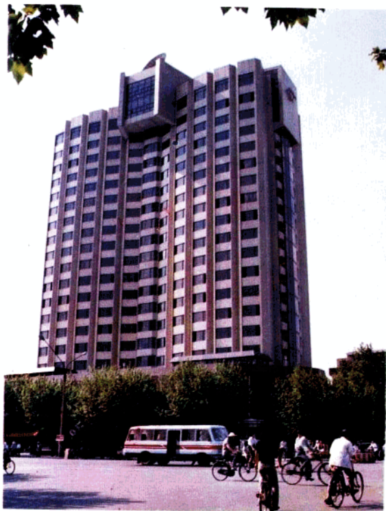
↑ 座落在市中心的蝴蝶大厦，1988年建成，总面积为2万平方米，高21层，顶层可俯瞰全市风貌。
