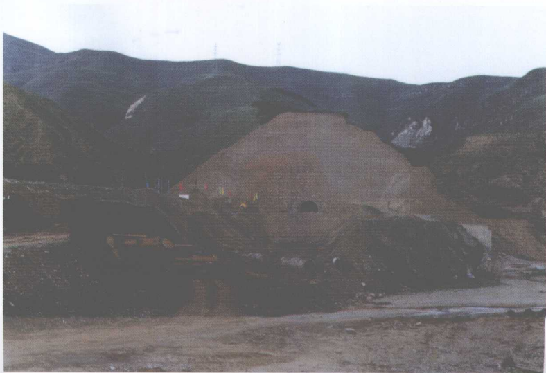
水泉河渡槽工程
