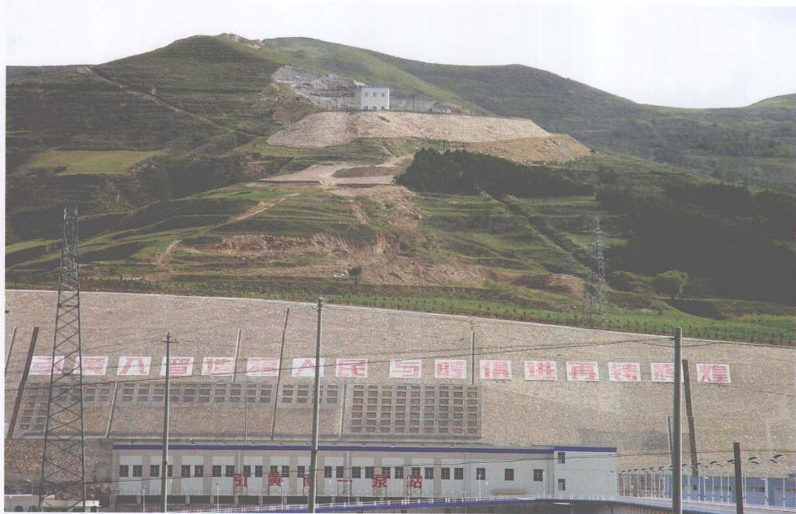
南干线一级泵站
