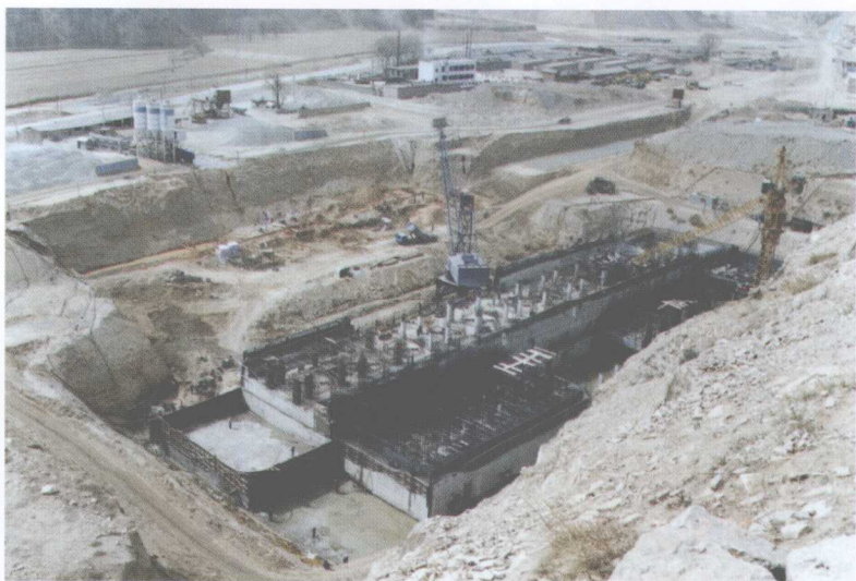
总干线三级泵站施工 场区
