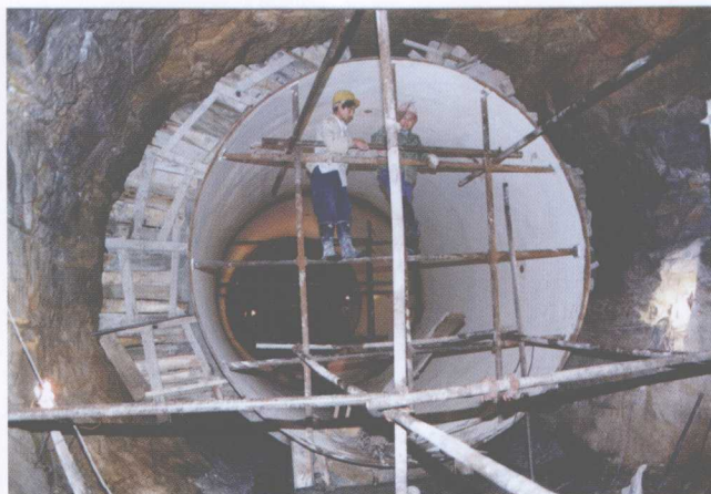
泵站高压钢衬管道浇筑混凝土
