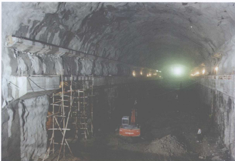
总干线一级泵站主厂房 第三层开挖后的景象
