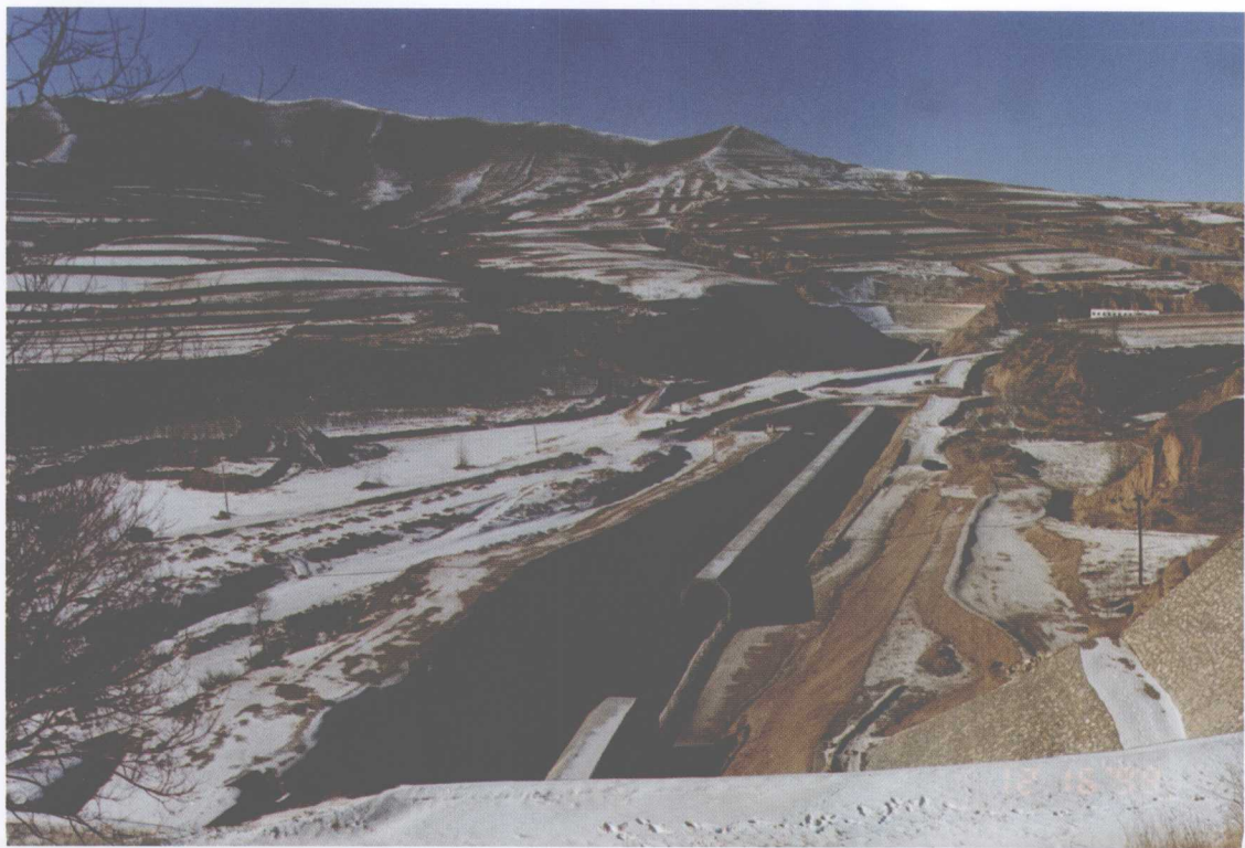
木瓜沟埋涵全景
