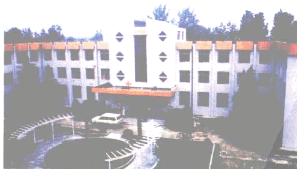
医院住院大楼
