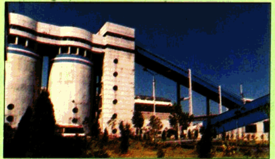
混煤仓及输煤栈桥
