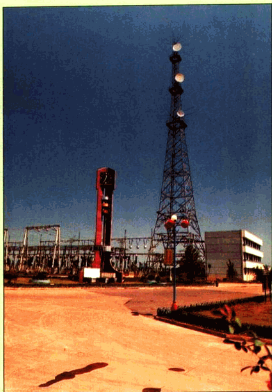
钟塔及微波塔
