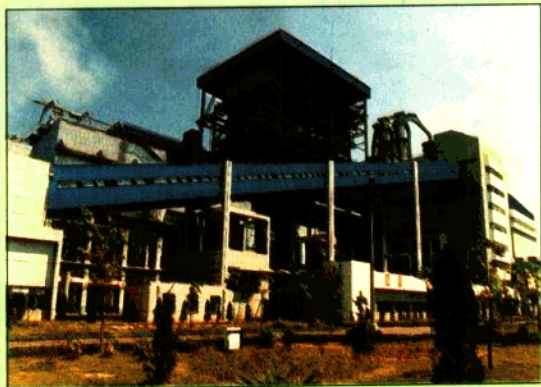
7号输煤栈桥及1号锅炉岛
