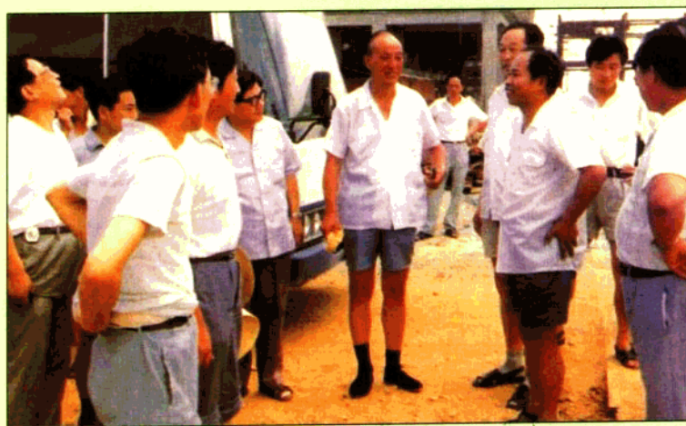
国家计委副主任郭树言视察电厂施工现场
